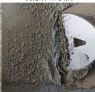
剥離作業状況
