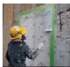
Step 2 下塗プライマー
